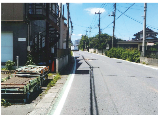
根金交差点～市道13号線交差点区間 歩車道境界ブロックがない箇所
