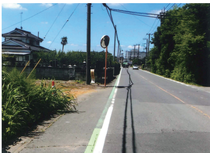
井沼交差点～浮張り団地入口区間 歩車道境界ブロックがない箇所
